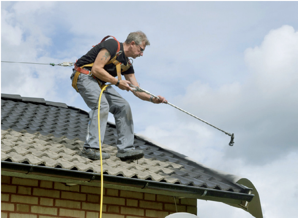
Ett tak målat med Hagmans betongtaksfärg.
